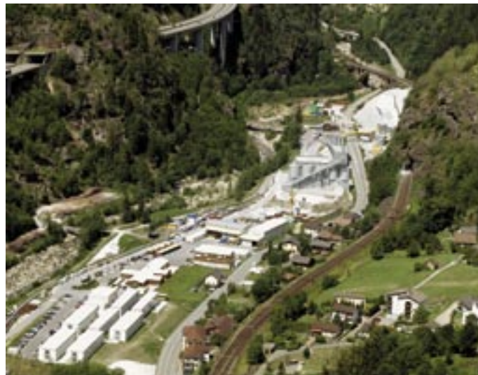
L'imposant chantier de l'entrée du tunnel à Faido.
